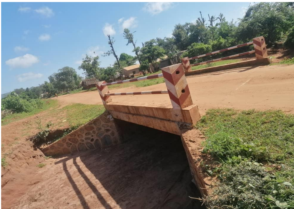
Daraja barabara ya Nakwa, 2022
