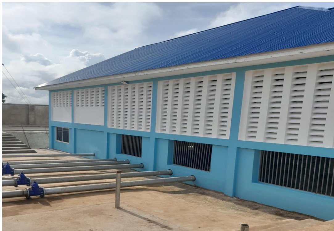
Picha: Nyumba kwaajili ya muunganiko wa mabomba (Pump House) Kijiji cha Singu
